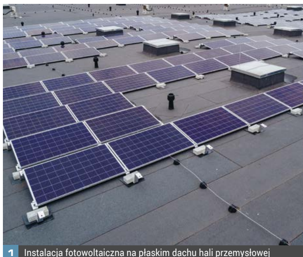
1 Instalacja fotowoltaiczna na płaskim dachu hali przemysłowej
