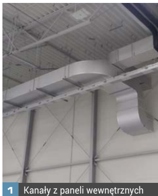
1 Kanały z paneli wewnętrznych
