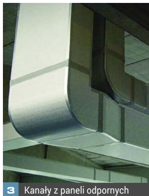
3 Kanały z paneli odpornych
