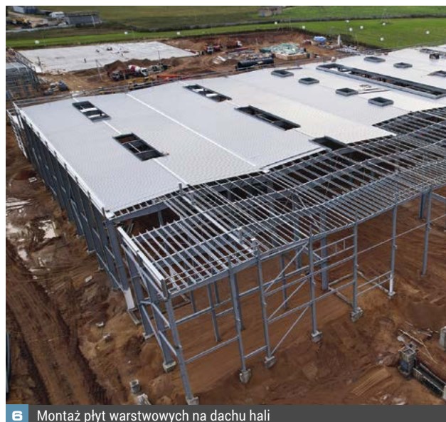
6 Montaż płyt warstwowych na dachu hali
