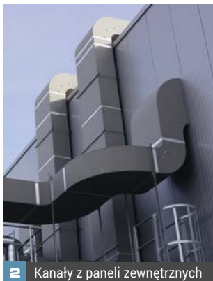
2 Kanały z paneli zewnętrznych
