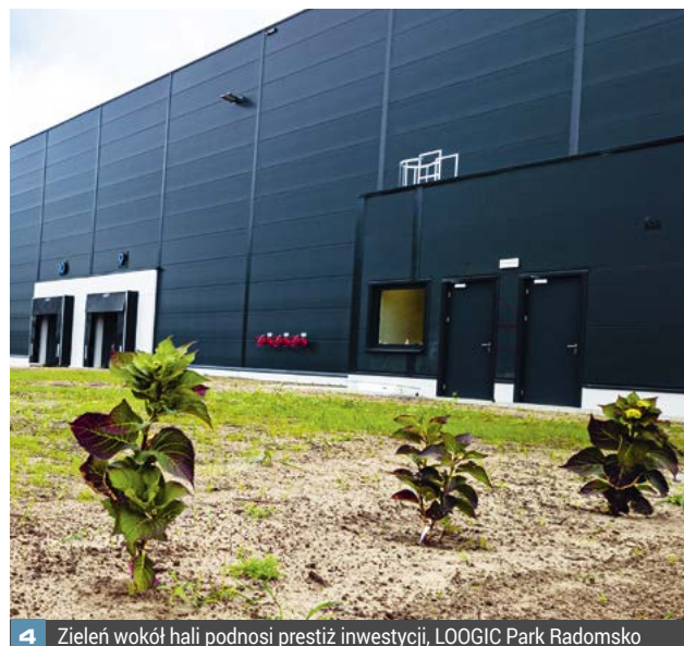
4 Zieleń wokół hali podnosi prestiż inwestycji, LOOGIC Park Radomsko
