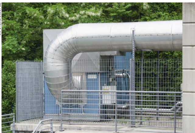
2 Instalacja doprowadzająca ciepłe powietrze do budynku
