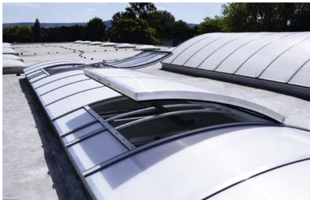
1 Klapy wbudowane w pasma świetlne pozwalają na przewietrzanie budynku i oddymianie go w czasie pożaru
