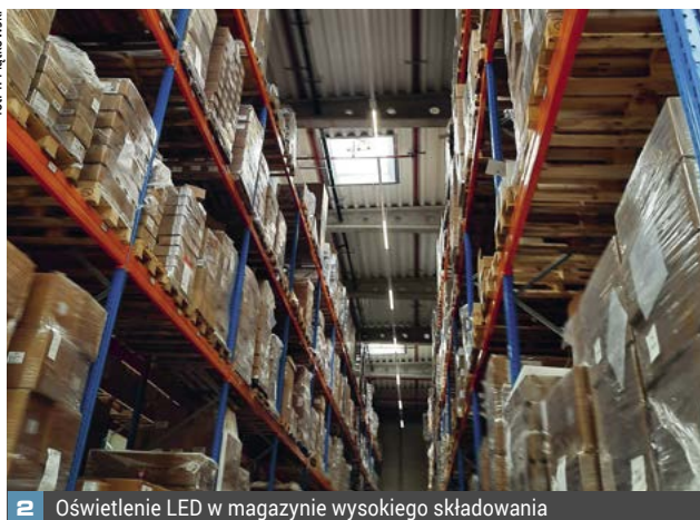
2 Oświetlenie LED w magazynie wysokiego składowania
