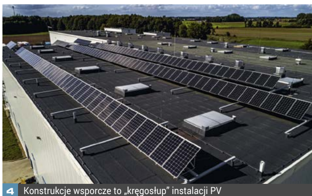
4 Konstrukcje wsporcze to „kręgosłup” instalacji PV
